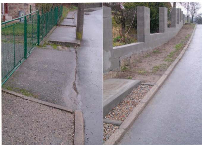
V obci jsme opravili chodníky z Kamenců až ke zvonici.
